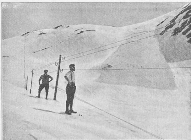
Fig. 1. — Versant ouest du col des Andérets. Traversée du plateau d'Isenau. Les 3 fils à haute tension et les 2 fils du téléphone de service. Hauteur moyenne de la neige : 4,50 m.
