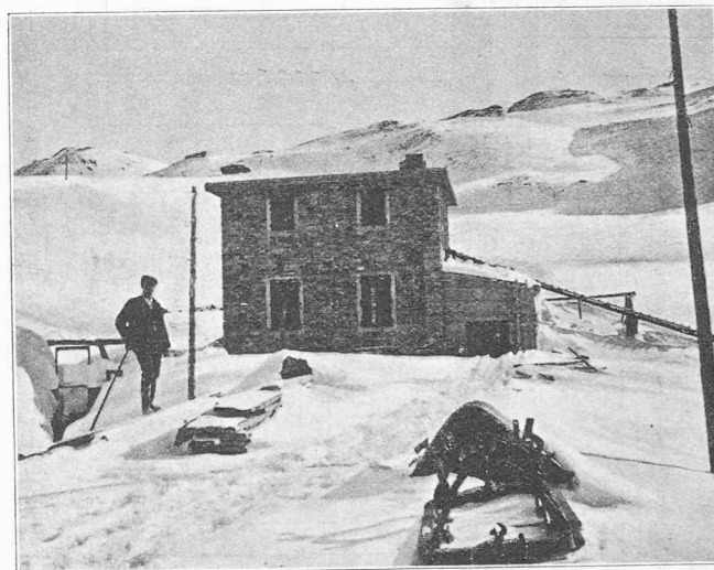
Fig. 22. — Station de pompage de Sorniot,
