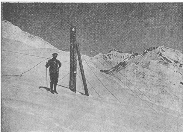
Fig. 26. — Poteau de 12 mètres et les lignes électrique et téléphonique rompues au Col des Andérets. Vue prise le 6 mai 1919.
