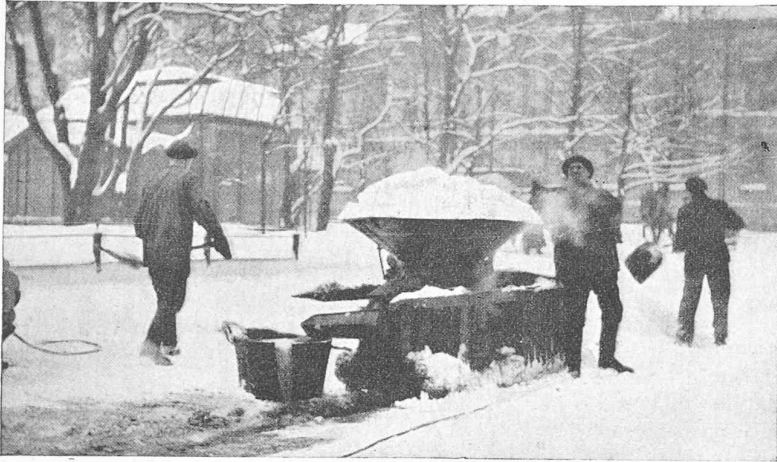
Fig. 1. — Machine « Fennia » pour la fusion de la neige.
