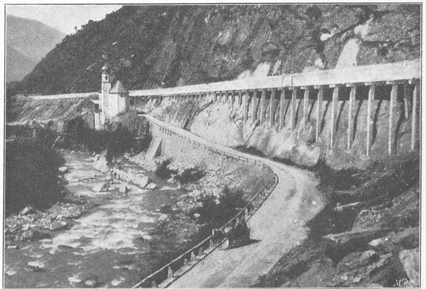
Fig. 2. — Aqueduc de Mœrel à Brigue.
