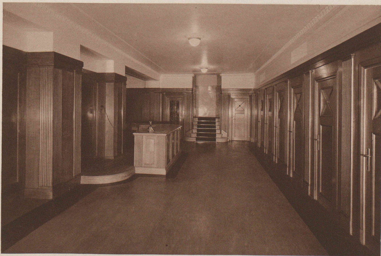
Cabines à disposition des locataires de coffres.
