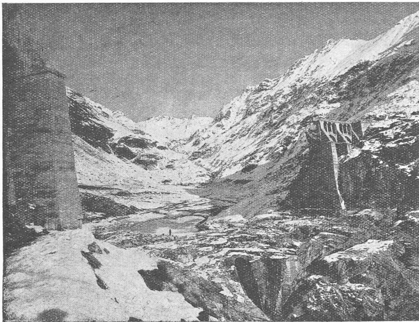
Fig. 8. — Vue, prise de l'aval, du barrage, après la catastrophe.
