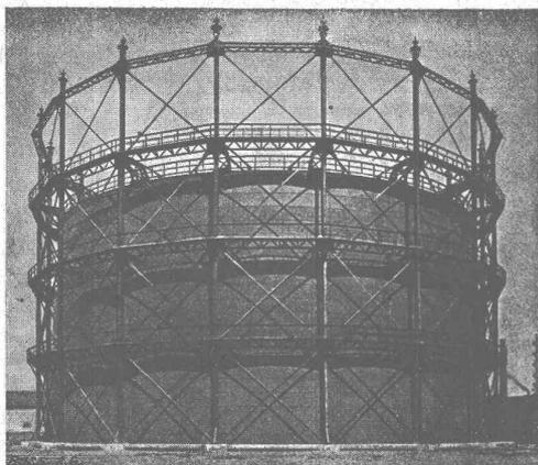
Gazomètre d'une contenance de 50,000 m<sup>3</sup>.
