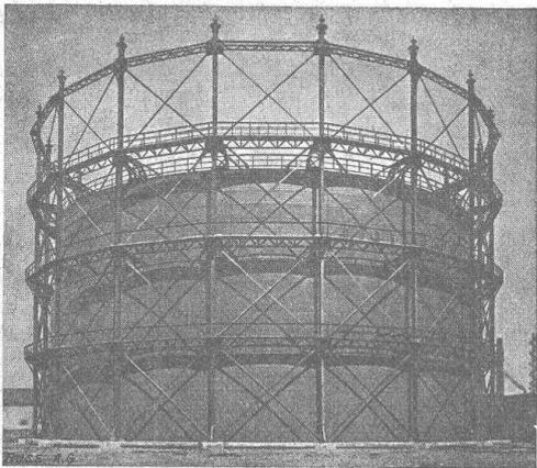
Gazomètre d'une contenance de 50,000 m<sup>3</sup>.
