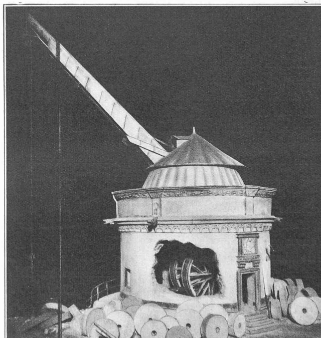
Fig. 1. — Maquette de la vieille grue d'Andernach, construite en 1554-57 et qui servit jusqu'à la fin du XIX e siècle à charger les meules taillées dans la lave basaltique.
