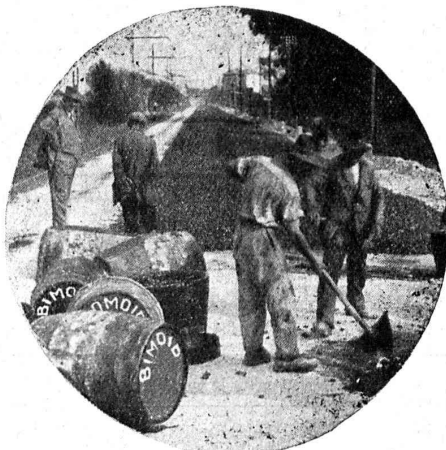
Revêtement par pénétration
