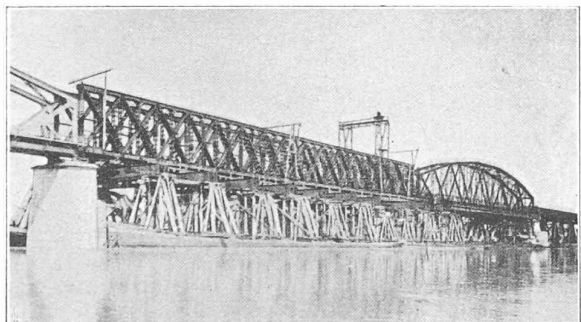
× Fig. 27 d. — Détails des travaux de remplacement, dont la vue générale est donnée par la fig. 27 c.
