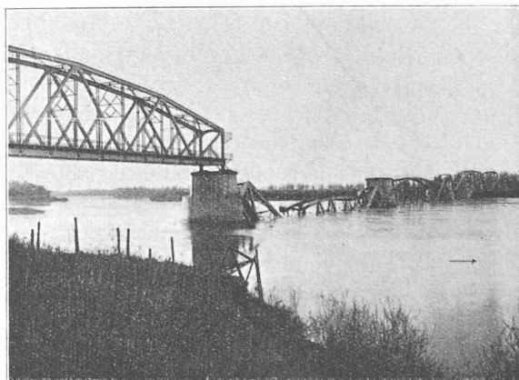
Fig. 27 e. — Pont sur la Save, près de Belgrade, destruction de l'ouvrage neuf « définitif » par les Autrichiens et les Allemands lors de leur retraite, en 1918. La réparation a été faite par un pont militaire semblable à celui de la fig. 27 b, qui fut remplacé par des travées définitives.
