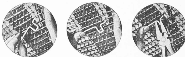
Fig. 16. — Opérations successives de fixation du lattis à l'aile inférieure des poutrelles.
