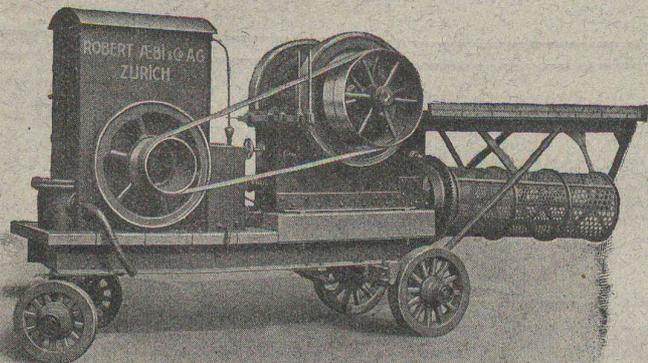
Coût du combustible pour la fabrication d'un m<sup>3</sup> de ballast avec le moteur « Uto » environ 14 centimes au lieu de 54 centimes environ avec moteur à benzine.
