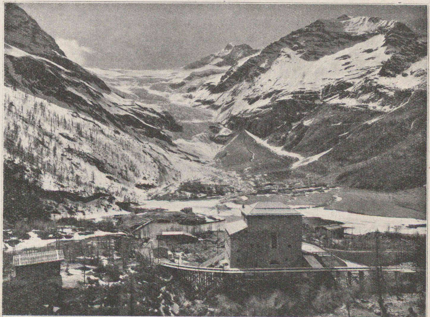
Fig. 4. — Vue de l'usine de Palü et du bassin de compensation. (Au fond, le glacier et le Piz de Palü.)
