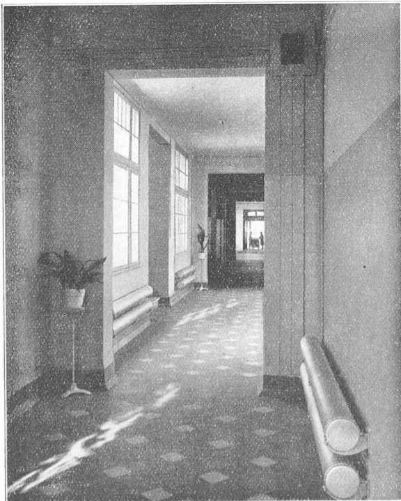
Fig. 3. — Chauffage d'un couloir par radiateur.
