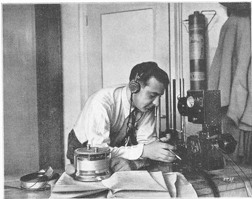
Fig. 4. — Appareil « Western Electric Moviola » employé pour le montage des films. Cet appareil permet au monteur de voir l'image et d'entendre ce qui a été enregistré sur la bande du sonore. On peut voir sur cette photo les deux bandes originales de vue et de son (gauche et droite).
