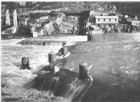
Barrage de Pinet sur le Tarn. Les sas des caissons pendant une crue de 800 m 3 , le 21 décembre 1927. (Cliché «Energie électrique du Rouergue S. A.».)
