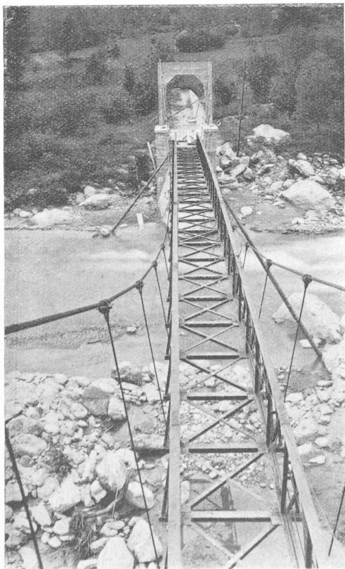
Fig. 1. — La poutre vue du haut d'un pylône. (On remarque sa largeur très réduite.)
