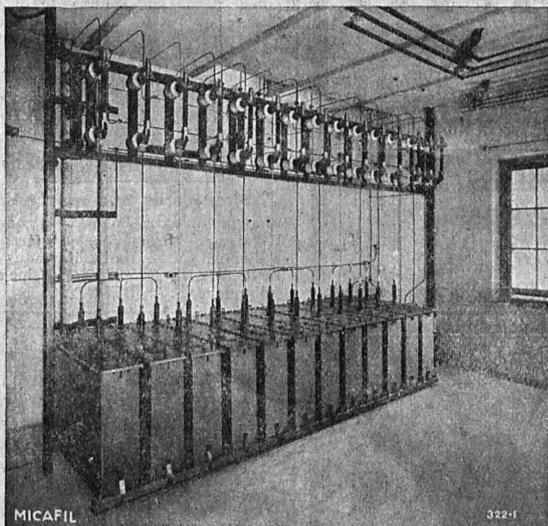
Batterie de condensateurs à haute tension MICALFIL, pour
