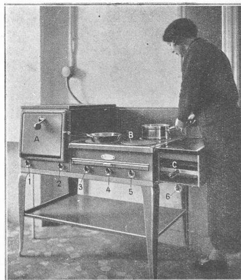
Fig. 3. — Type des cuisinières électriques desservant l'immeuble d'Issy-les-Moulineaux.
