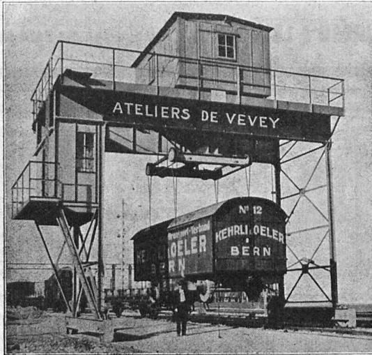
GRUE A PORTIQUE ROULANT, 40 T., DE LA GARE DE WEYERMANSHAUS, A BERNE
