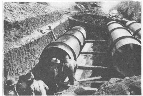
Fig. 17. — Chargement des tuyaux de Saleinaz.
