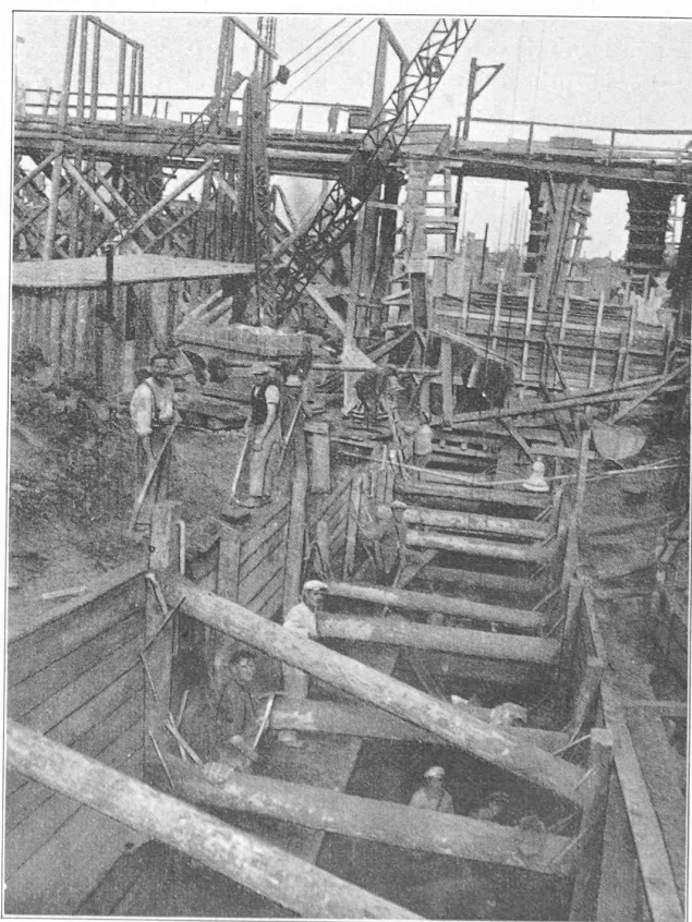
Fig. 12. — Fouille blindée du mur de rive droite amont. Photo Dickerhoff & Widmann (Berlin).
