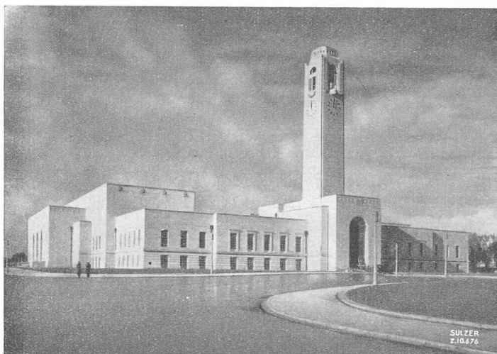
Fig. 3. — Swansea Civic Centre.
