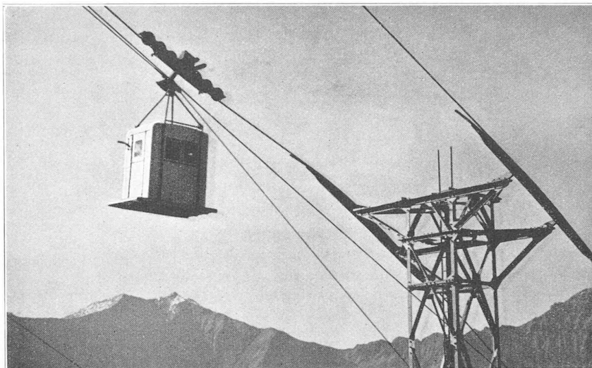
Fig. 4. — Cabine au passage du pylône.
