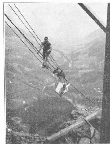
Fig. 7. — Montage d'un câble porteur.
