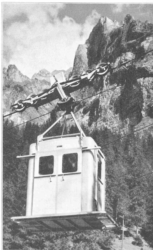
Fig. 3. — Cabine sortant de la station inférieure. Photo E. Gyger, Adelboden.
