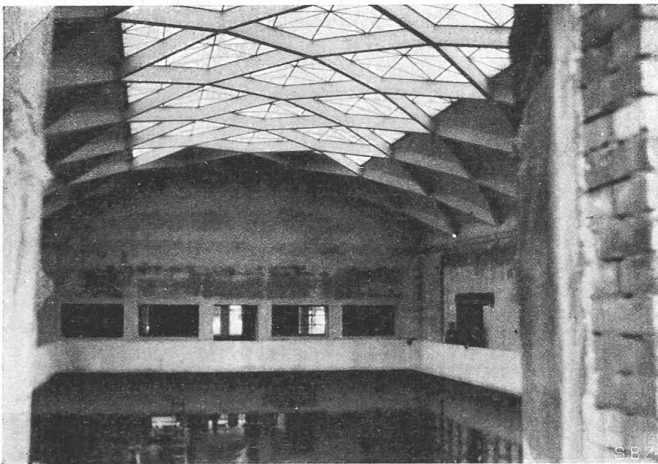
Fig. 4. — Toiture de l'Université de Kaunas (Lithuanie) ; portée 20 m, hauteur utile 50 cm, pas de poussée horizontale.
