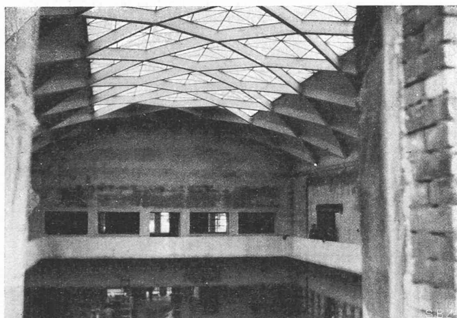
Fig. 4. — Toiture de l'Université de Kaunas (Lithuanie) ; portée 20 m, hauteur utile 50 cm, pas de poussée horizontale.
