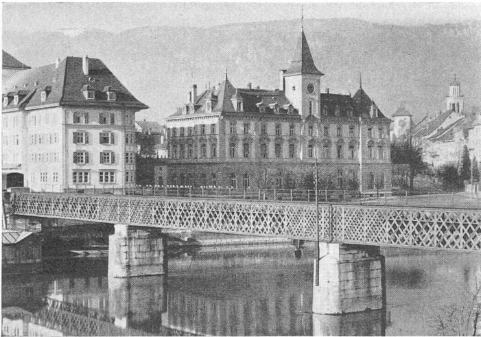
L'ancien pont, à voie unique.
