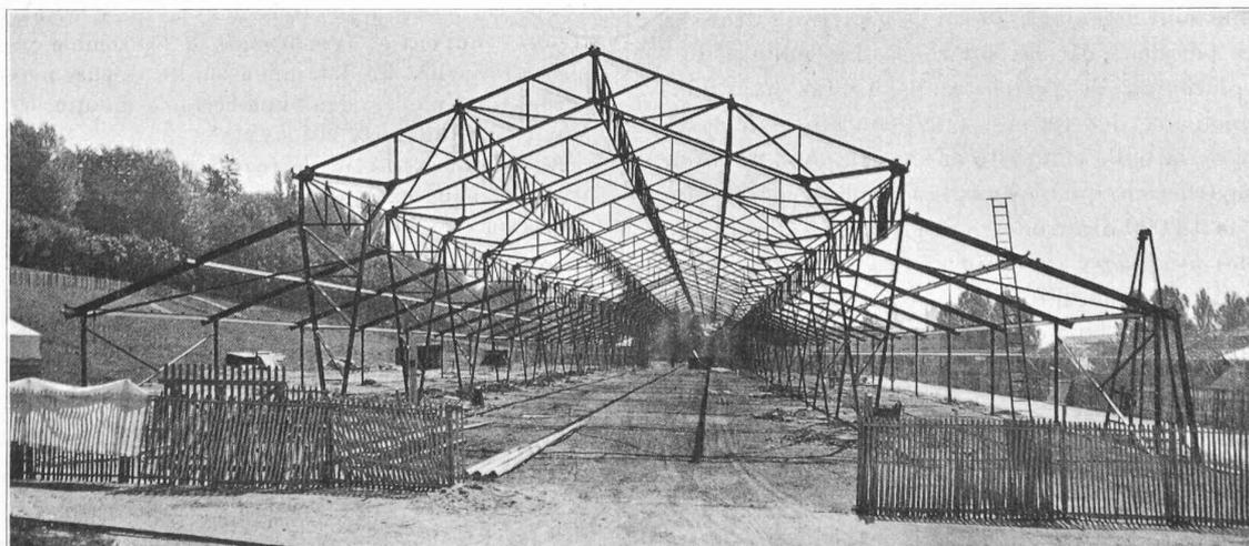
Fig. 1. — Vue de la halle centrale montrant le système constructif comprenant les fermes et les pannes à treillis. Les séparations des éléments sont marquées par les goussets d'attache aux membrures.
