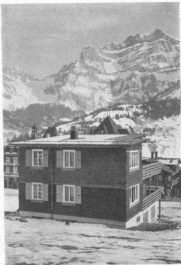
Chalet à Adelboden (altitude env. 1400 m.) couvert avec TECUTA 0,40 mm.
