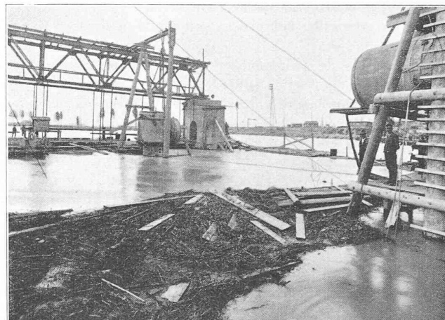
Fig. 20. — Fouille du seuil 4 inondée lors d'une crue du Rhin.
