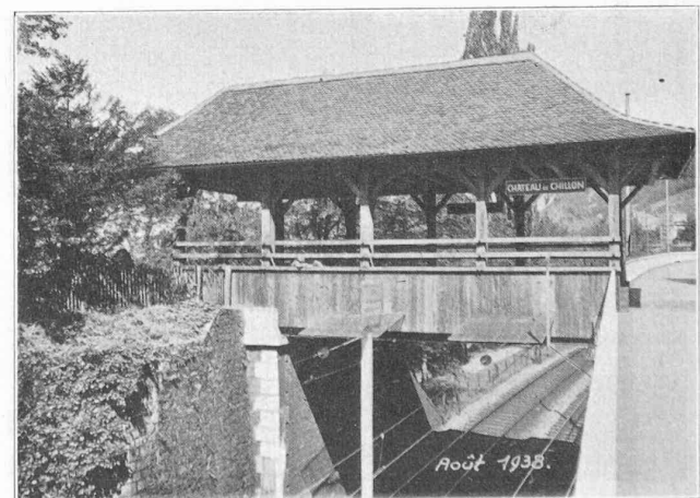
Fig. 5. — Le nouveau couvert en bois du Château de Chillon.
