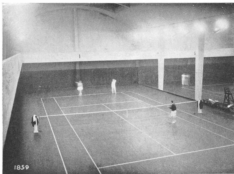
Fig. 1. — Court d'entraînement. La vue montre que l'éclairage est bon, quant au sol. Le filet et les personnes se détachent bien. Seul, le film pourrait rendre l'éclairage que reçoit la balle en mouvement.
