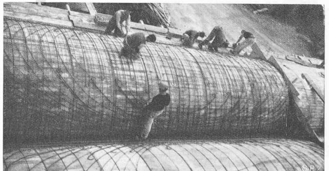
Fig. 15. — Pose des barres d'armature dans les panneaux nord.
