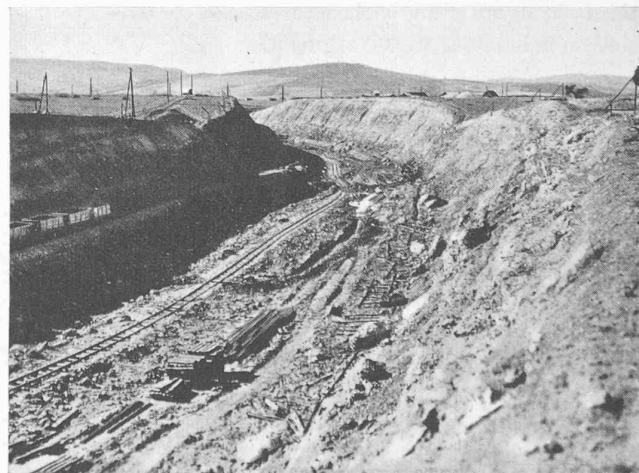
Fig. 8. — Vue générale du tronçon central du canal de fuite durant les travaux d'excavation.
