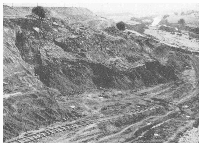
Fig. 9. — Vue des glissements de terrain du tronçon aval du canal de fuite (17 mars 1937).
