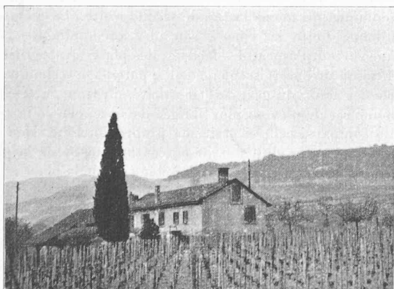
Dans le vignoble, la construction de hauteur limitée. Près de Rolle.
