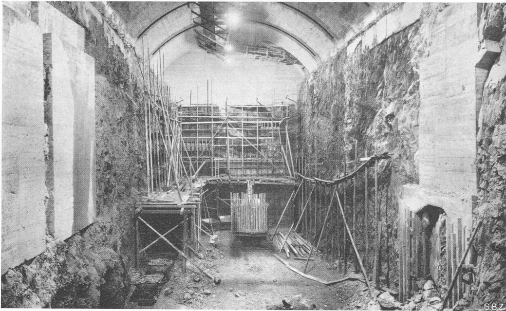
Fig. 16. — Exécution des revêtements de la salle des machines.
