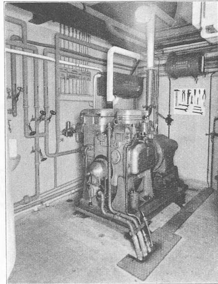
Fig. 3. — Salle des machines : groupe électrogène de secours.
