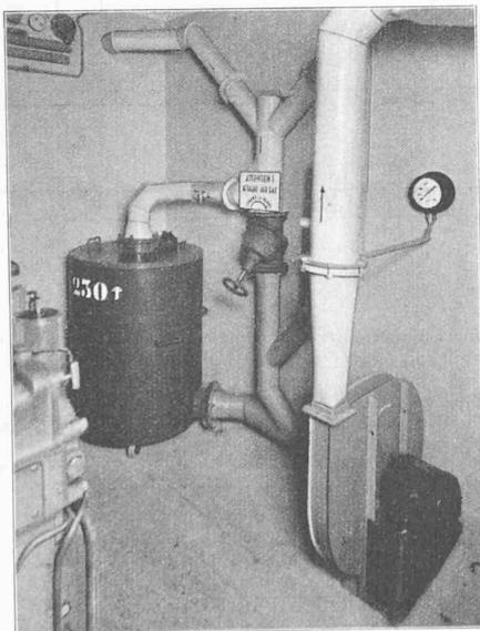
Fig. 2. — Salle des machines : ventilation et filtre anti-gaz.
