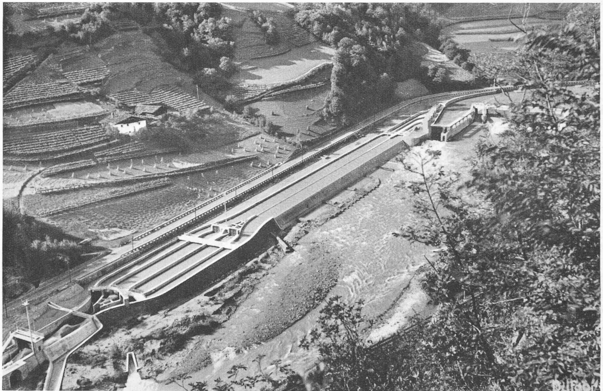
Fig. 4. — Vue sur l'ensemble de l'installation. Bassin versant du torrent env. 3000 km 2 . Débit dérivé 100 m 3 /sec.
