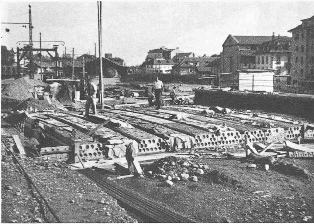
Fig. 3. — Pont de Fribourg. Poutres avant la mise en tension.
