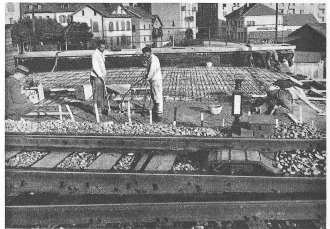
Fig. 7. — Pont de Fribourg. Bétonnage de la dalle mince de liaison.
