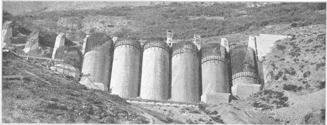
Fig. 3. — Barrage-voûte de Beni-Bahdel. Vue d'amont. Ouverture des voûtes 20 m.
