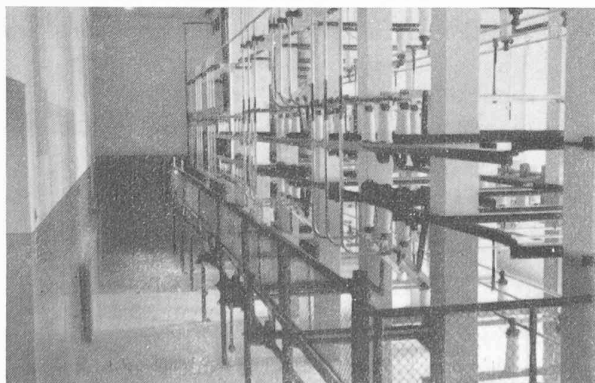
Fig. 10. — Sectionneurs et barres 13 kv.
