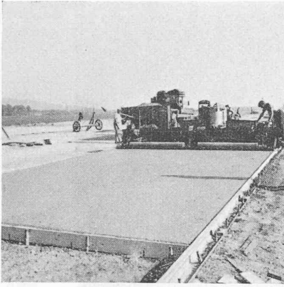
Fig. 8. — Machine Lakewood pour le réglage, le damage et le surfacage du béton.
