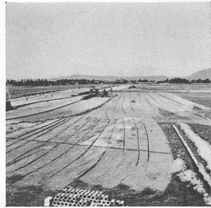
Fig. 12. — Vue générale du chantier.
