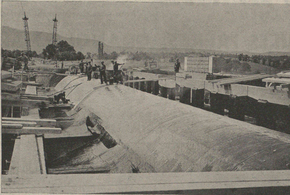
Revêtement étanche sur route de pont.
