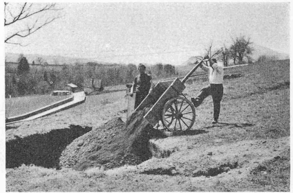
Fig. 9. — Remblayage des trous en surface. Remarque la fissure limitant les affaissements au S.-W., à 10 m des murs de soutènement et exactement au-dessus de la limite du dépilage.
