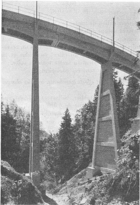
La plus haute palée vue de profil (flambage).
