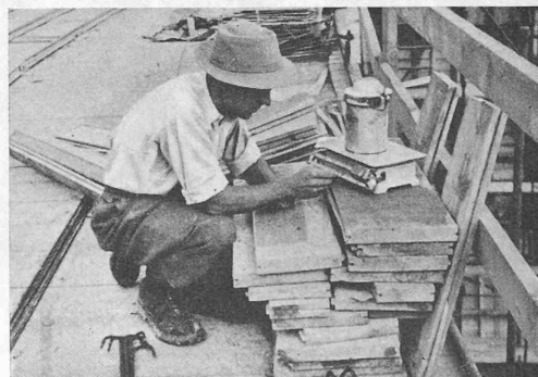
Contrôle de la quantité d'eau par la densité du béton frais.
