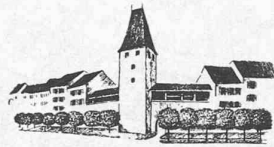
Mise en valeur de la Tour Barraux.
