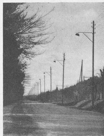
Fig. 7. — Luminaires montés sur poteaux et avancés par consoles métalliques.
