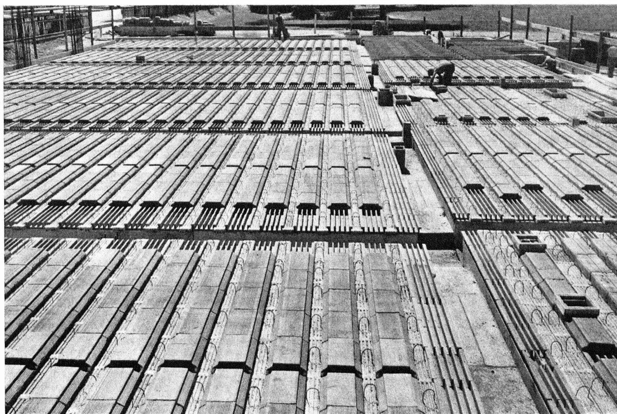
Exécution du plancher d'une salle de gymnastique en dalles STAHLTON — STHALTON-WERK BERN A. G., Berne-Lieberfeld Photographie Alfred Löhndorf, Bâle
